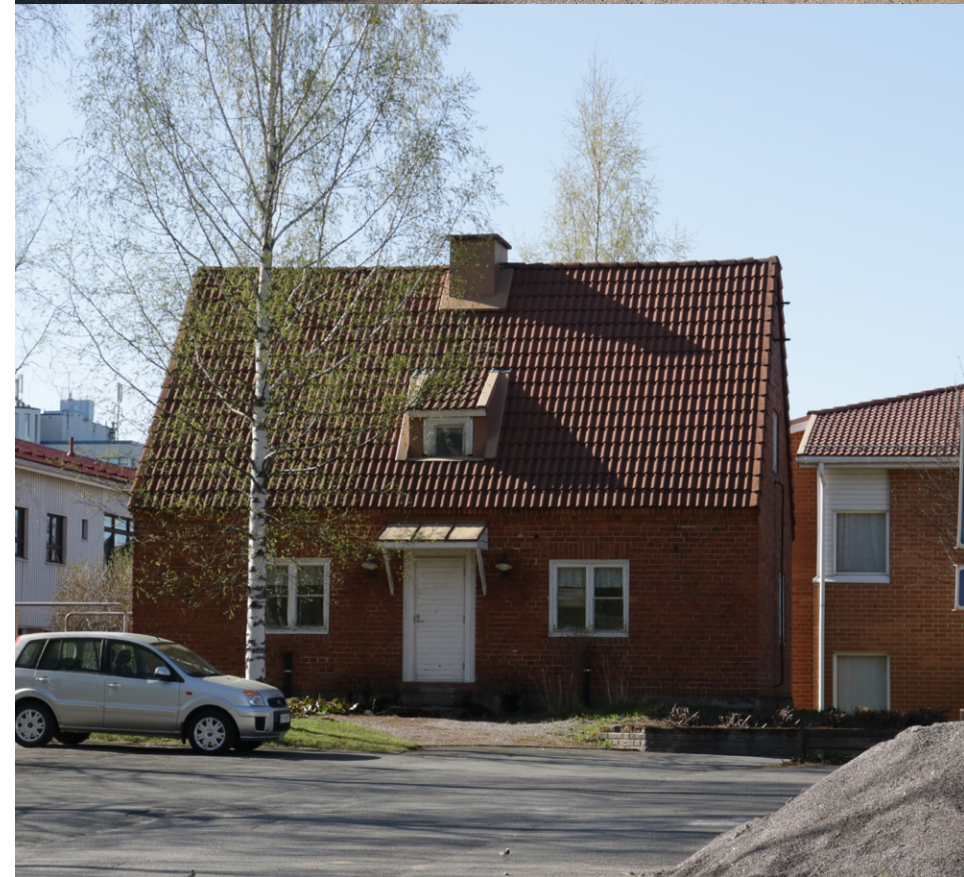
Yllä: Vanutehtaan vanhempi osuus (rakennettu 1920)
